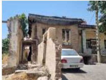
شکل ۹- نمایی از خانه‌های تخلیه شده در محدوده پلاک ثبتی دانشگاه پس از اجرای حکم قلع و قمع-نگارندگان، ۱۴۰۴
